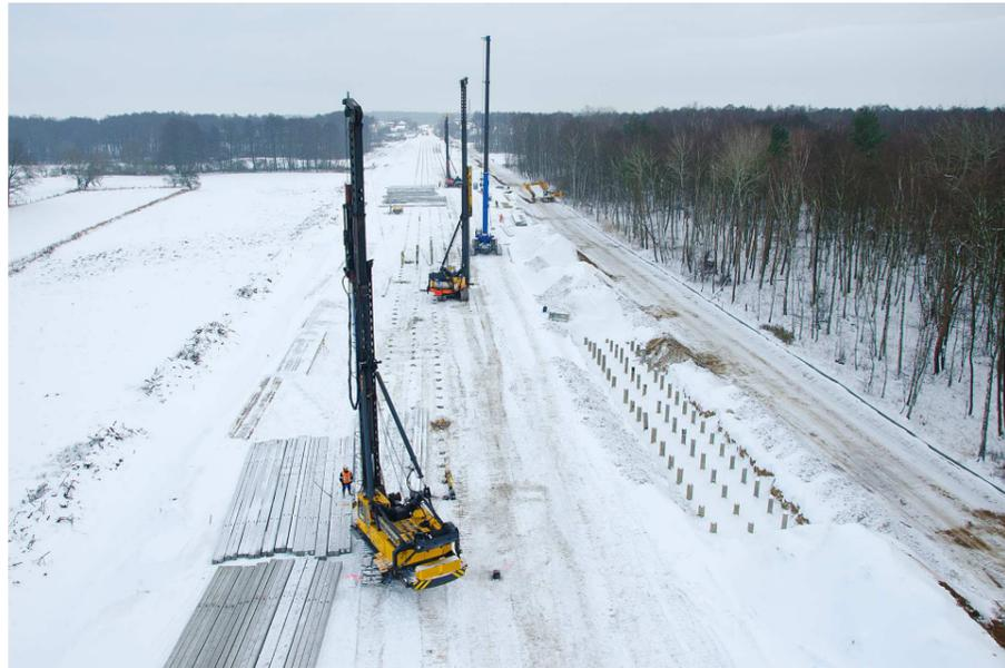
Bild 6: Rammarbeiten im Moor 3 (Quelle: Centrum Pfähle GmbH)
