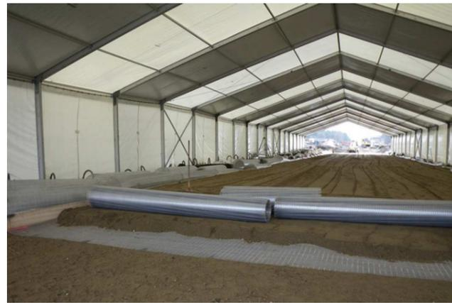
Bild 8: Einbau der Geogitter
