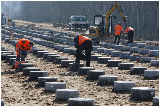
Bild 7: Herstellen der Pfahlköpfe aus Fertigteilen
