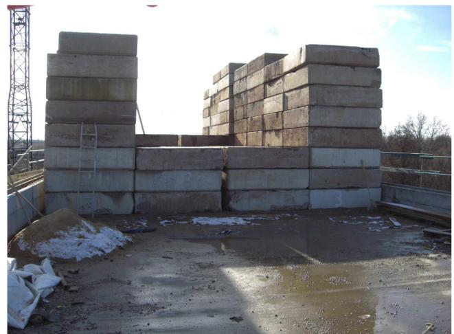
Abbildung 7: Vorbelastung mittels Betonplatten an der AA 32
